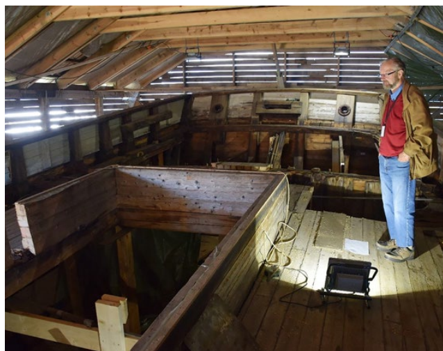
Konservator Oscar Berg ved Nordlandsmuseet inspiserer det pågående restaureringsarbeidet. Foto: Nordlandsmuseet.
